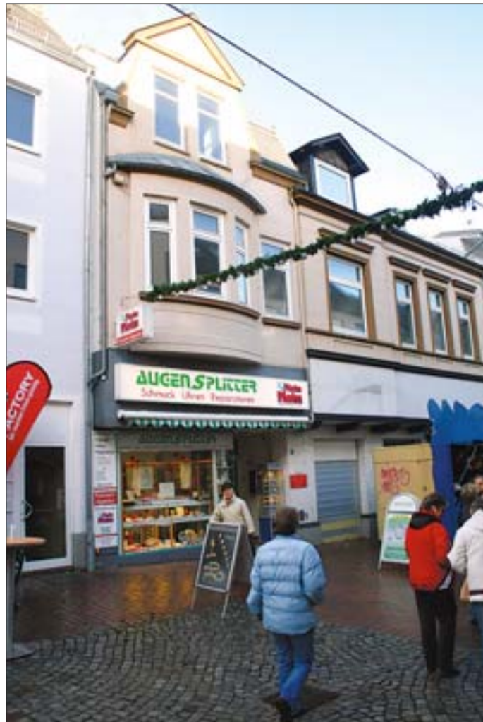
Dieses Gebäude im Stadtweg 62 wird im Januar abgerissen. Pünktlich zur Landesgartenschau werden dann Lärm und ein Bauzaun die Touristen und Besucher in der Ladenstraße »begleiten«. FOTO: WEIDE
