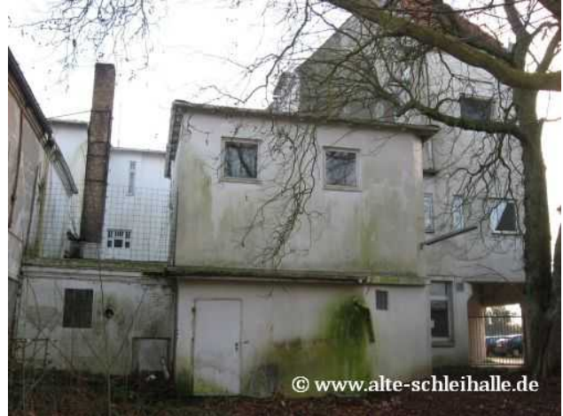
Unter dem Gebäudeteil befand sich der Eiskeller (2008).
