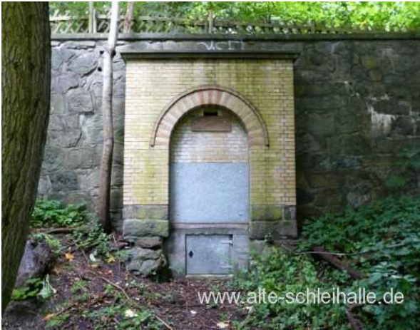
Der verschlossene Eingang zu den Lagerstollen.
