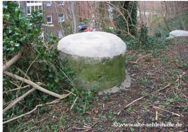
Die beiden verschlossenen Luftschächte der Längsstollen.
