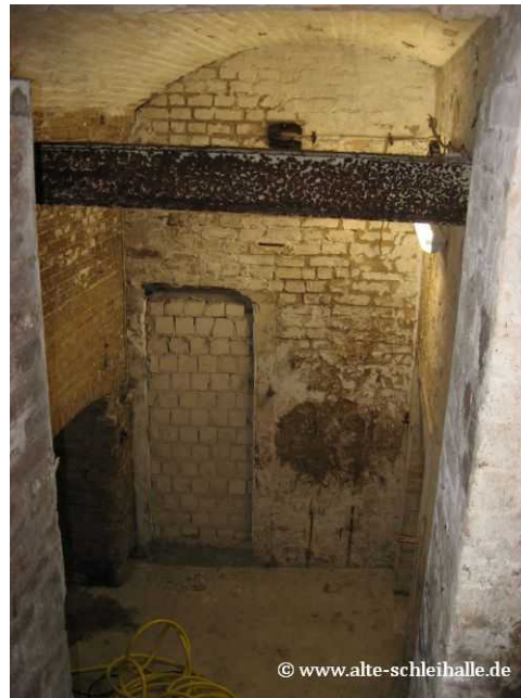
Blick von der Treppe, links Lagerkeller, rechts Eiskeller.
