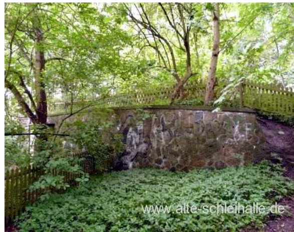
Wo 1896 der teilweise überirdische Eiskeller errichtet wurde, befindet sich 2011 eine Feldsteinmauer.
