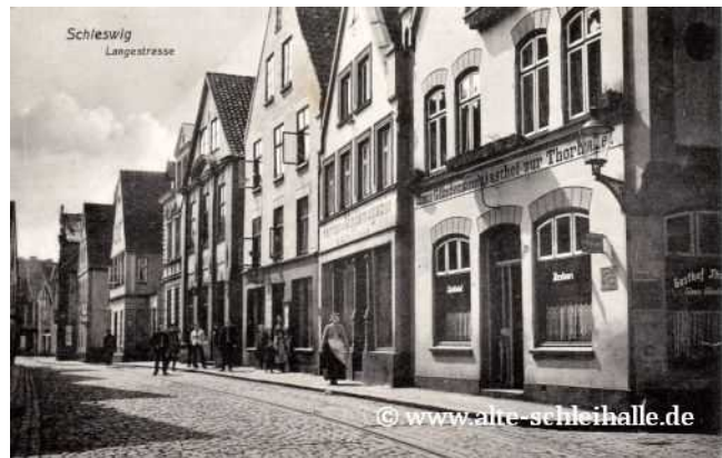
Die Gaststätte "Torhalle", Lange Straße 25.
