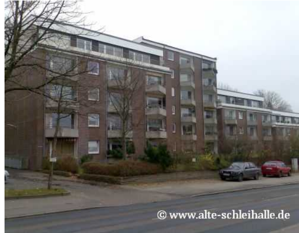
Appartementhaus Flensburger Straße 6 (2007).
